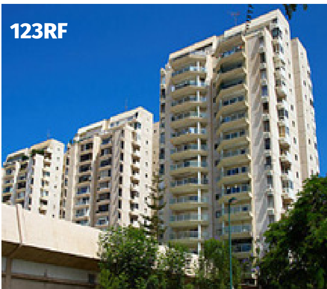
Condomínio, empresa de segurança e vizinho indenizarão por furto
